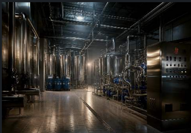
Здание СИП-станции (фильтрационное отделение)
