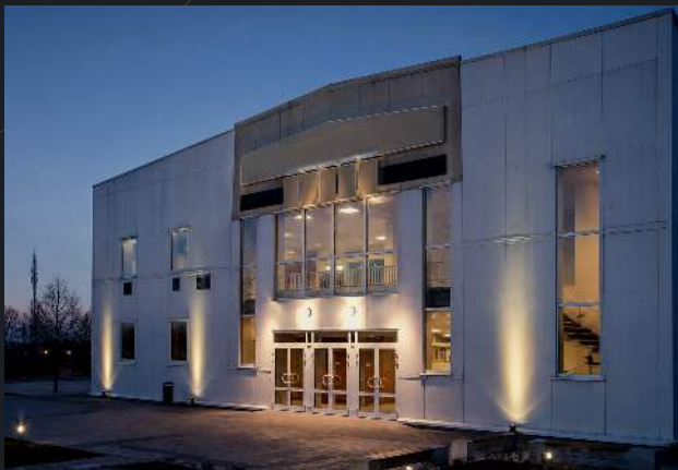
АБК складского терминала
