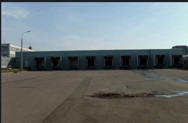
Реконструкция складского комплекса 2-й очереди агропромышленного предприятия
