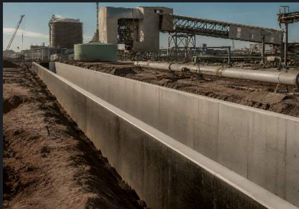
Строительство водозаборного сооружения
