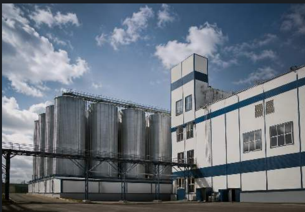
Производственные корпуса «Балтика-Тула»
